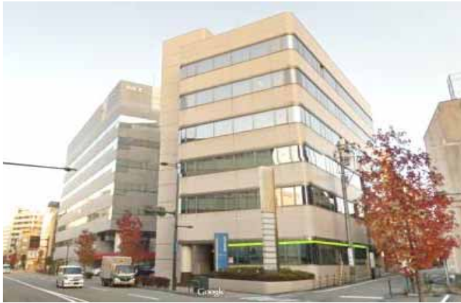
金沢支店(外観)
